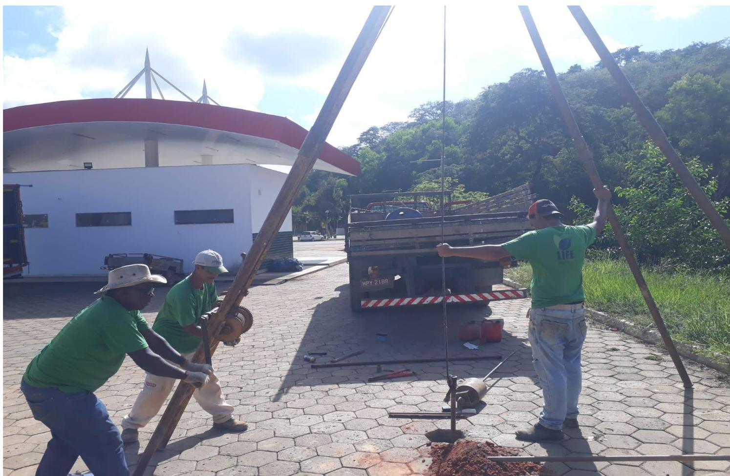
Imagem 01: Imagem mostra os trabalhos sendo realizados no SPT 01, com o término das atividades com a cabeça de bater e amostragem direta, com contagem de golpes.
